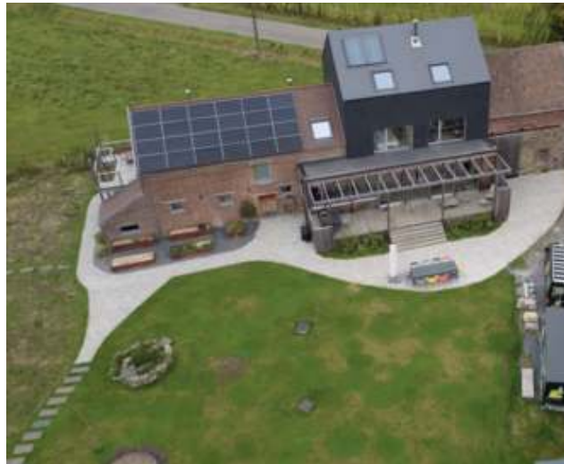
Le couple a dû mettre la main à la pâte pour rénover cet ancien bâtiment. © D.R.
